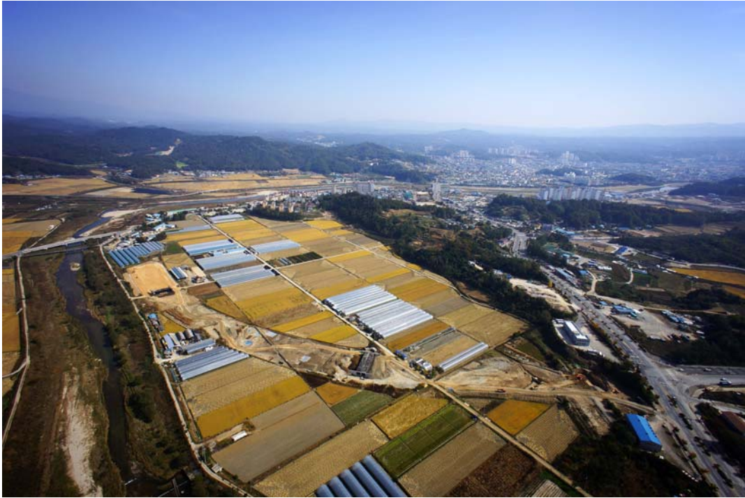
영주 가흥-상망 간 우회도로 공사구간
