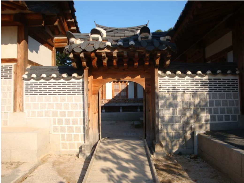
건청궁 협문(복수당 서행각과 곤녕합 복도각 사이) 전경
