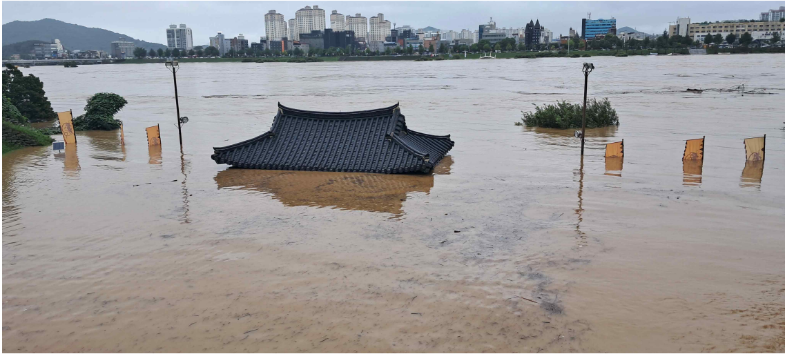
< 올해 집중호우로 인한 '공주 공산성'(사적) 만하루 침수 모습 >
