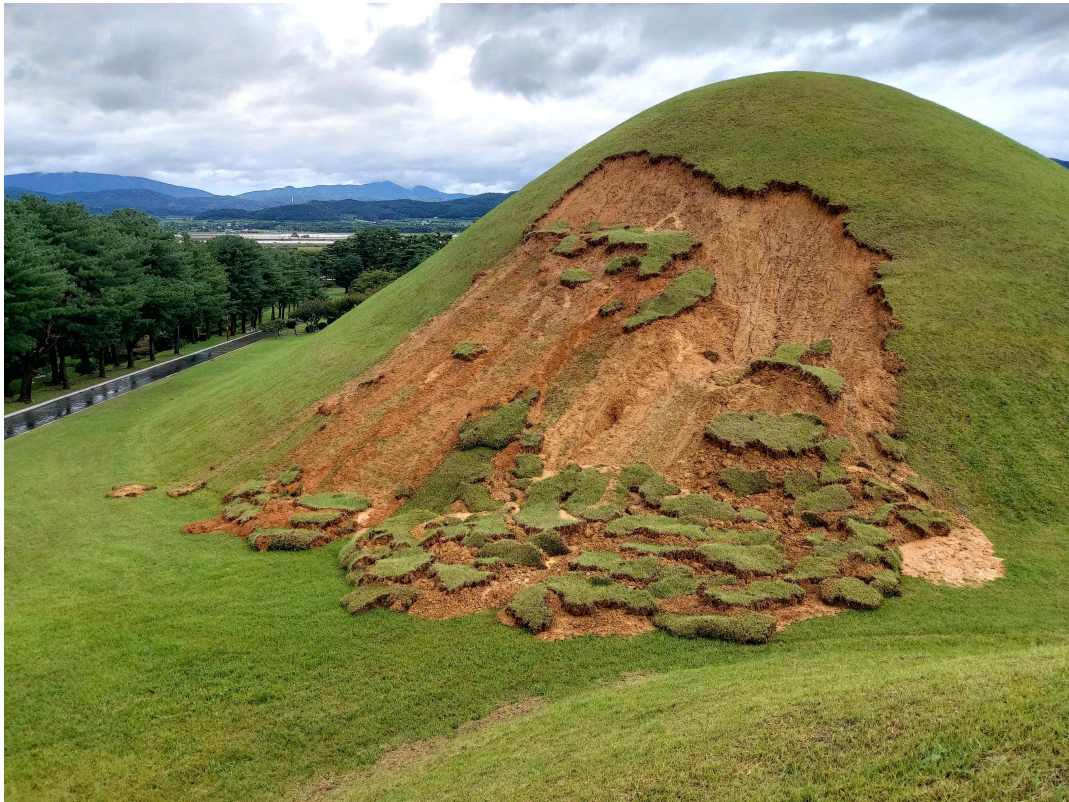
< 지난해 태풍 힌남노로 인한 '경주 서악동 고분군'(사적) 유실 모습 >
