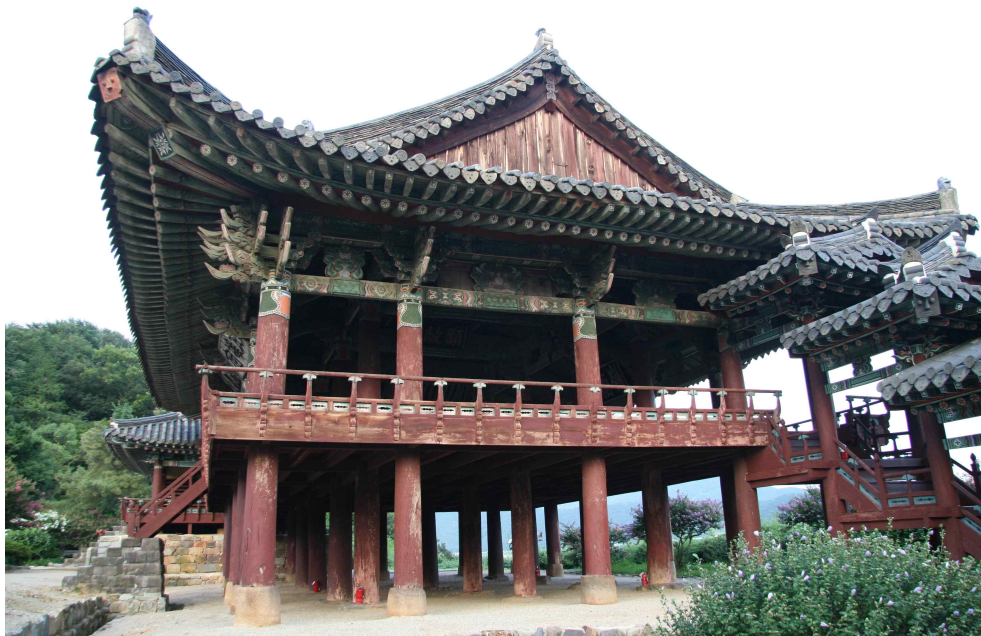
< 밀양 영남루 본루 측면 전경 >
