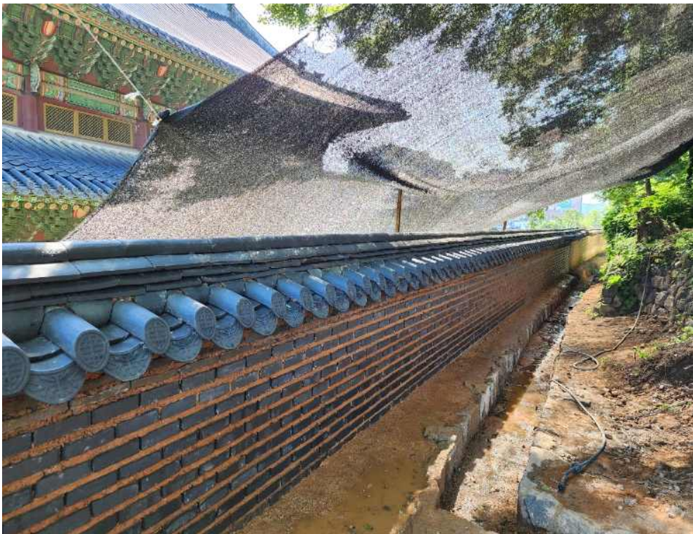
<창덕궁 인정전 배면 담장 호우피해 부분 지붕 기와 설치 후>
