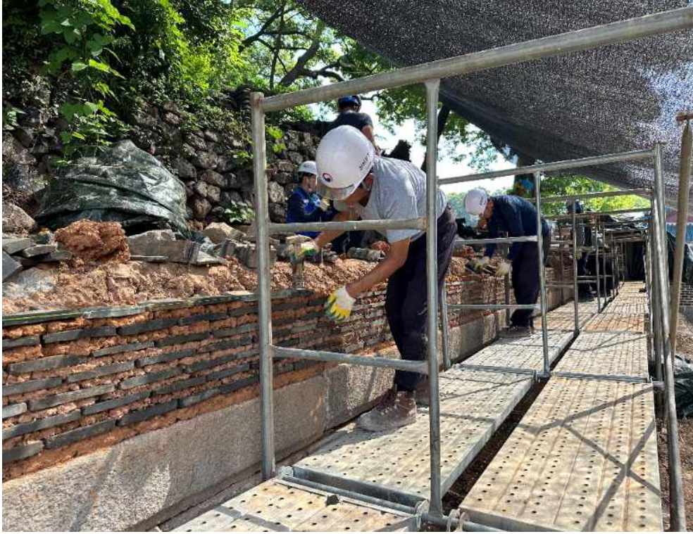
<창덕궁 인정전 배면 담장 호우피해 부분 외편 쌓기 중>
