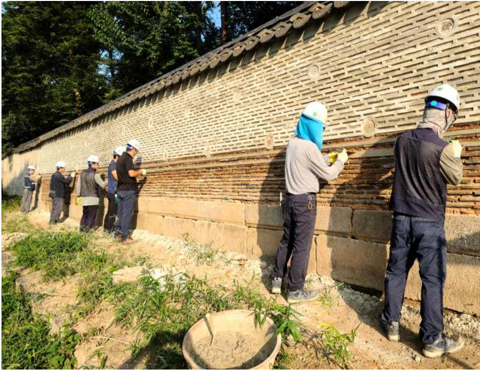
<창덕궁 인정전 배면 담장 호우피해 부분 줄눈 바르기 중>
