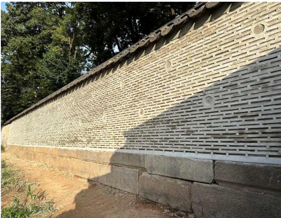
<창덕궁 인정전 배면 담장 호우피해 부분 해체 보수 완료>
