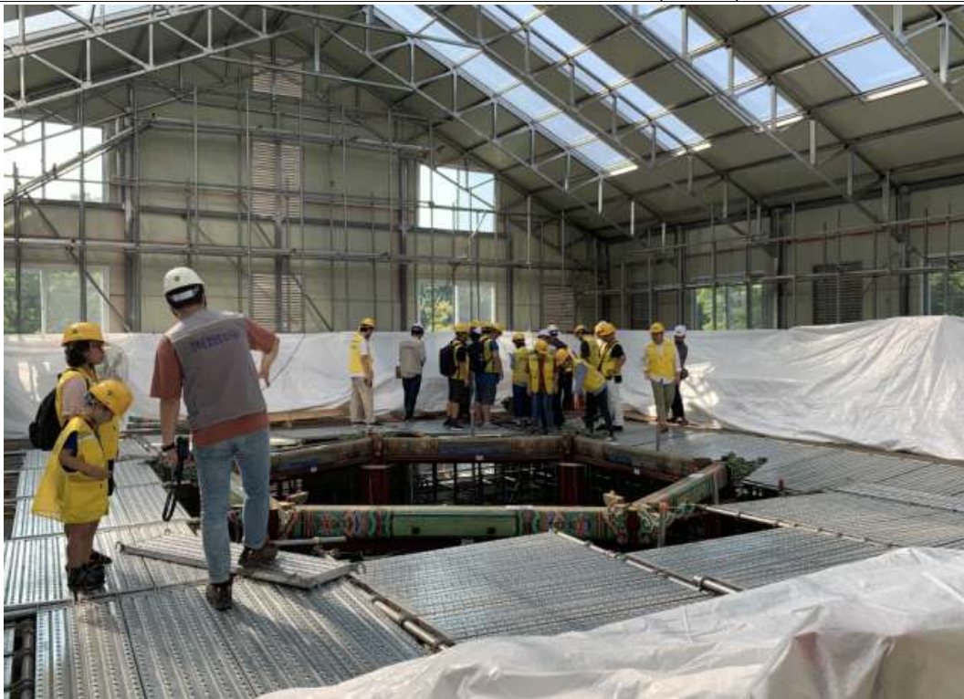
경복궁 향원정 보수 공개관람('19년)
