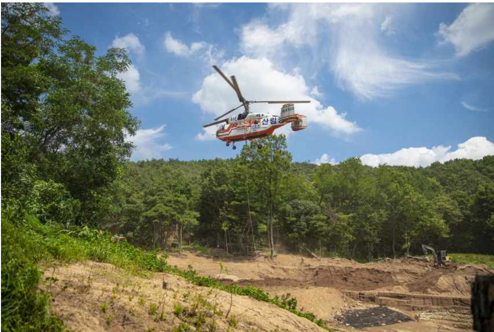
<대구 팔거산성 목부재 이송 현장>
