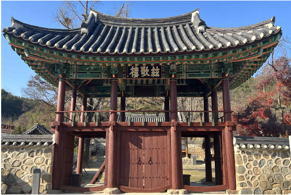
<전통단청 시공 사진 : 정읍 무성서원 현가루(2021년)>
