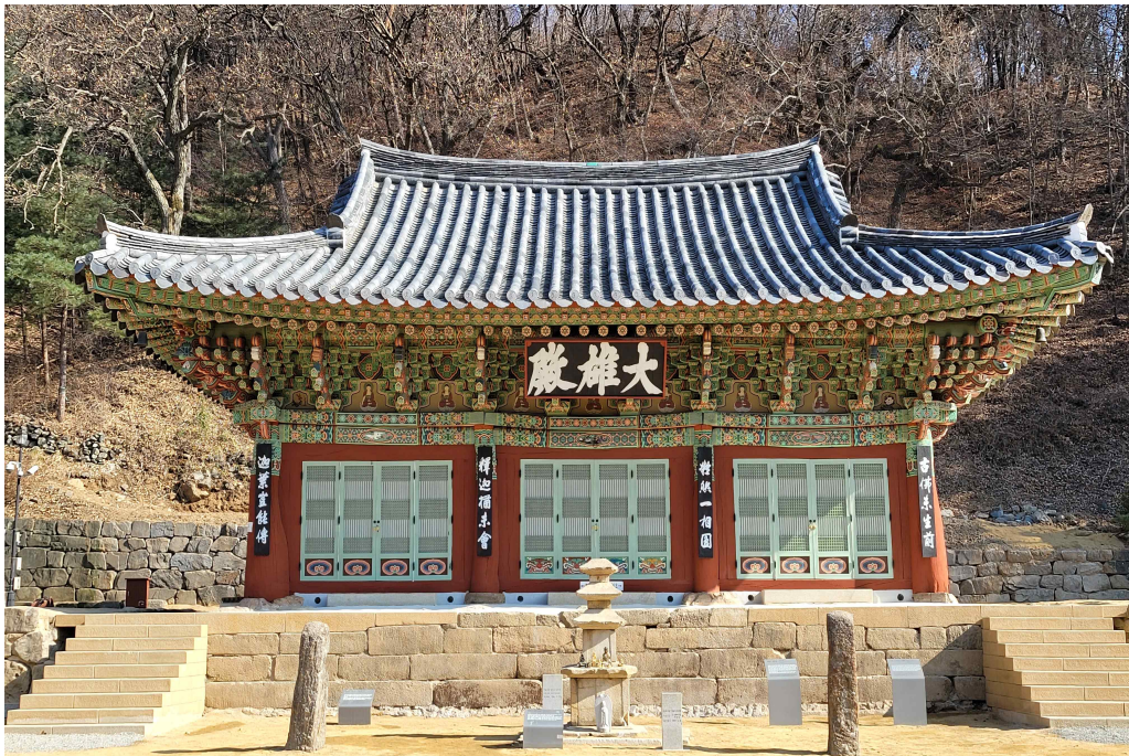
<전통단청 시공 사진 : 안성 청룡사 대웅전(2021년)>
