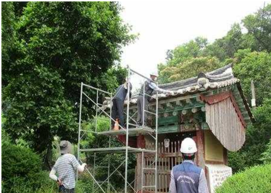
<기와보수(와구토) 현장 점검·자문>
