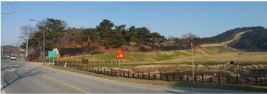
<부여 나성 정비 대상구간 전경>
