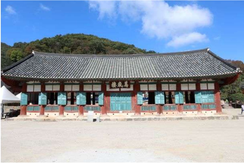
<국가지정문화재 보물 제2065호 고창 선운사 만세루 전경(정면)>
