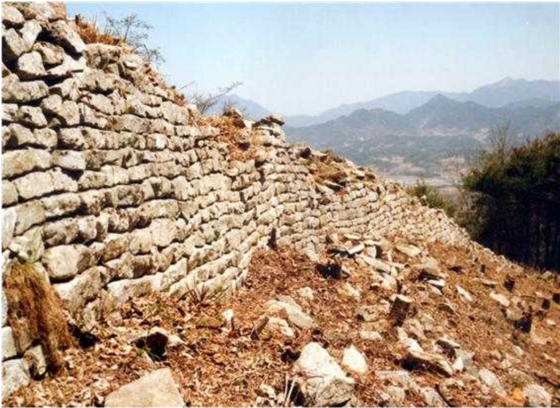
<거열산성 2차성 성벽 전경>
