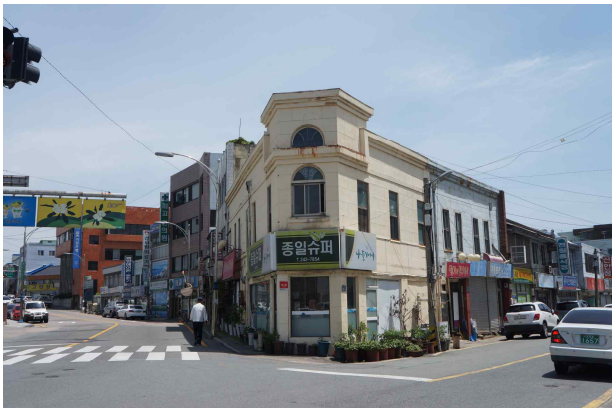
<2-10. 목포 해안로 교차로 상가주택>
