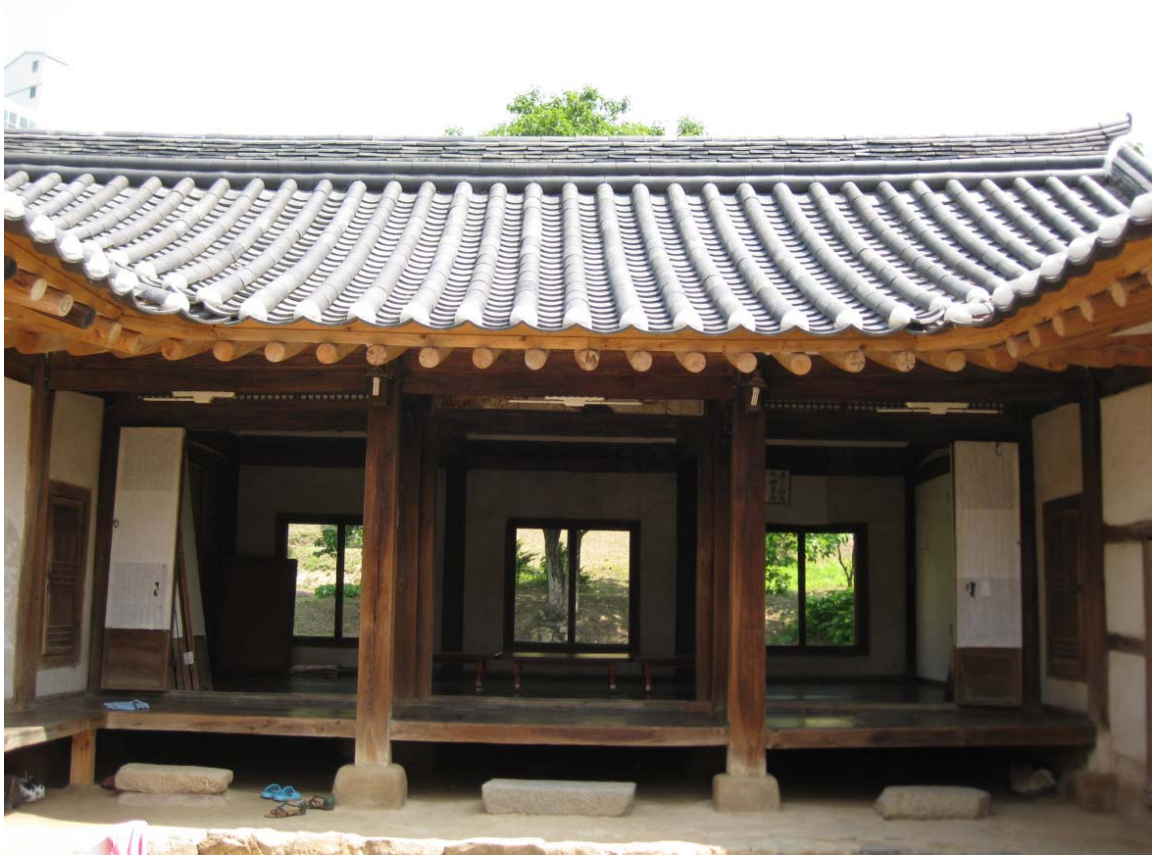
<대전 동춘당 종택 안채 전면 전경>
