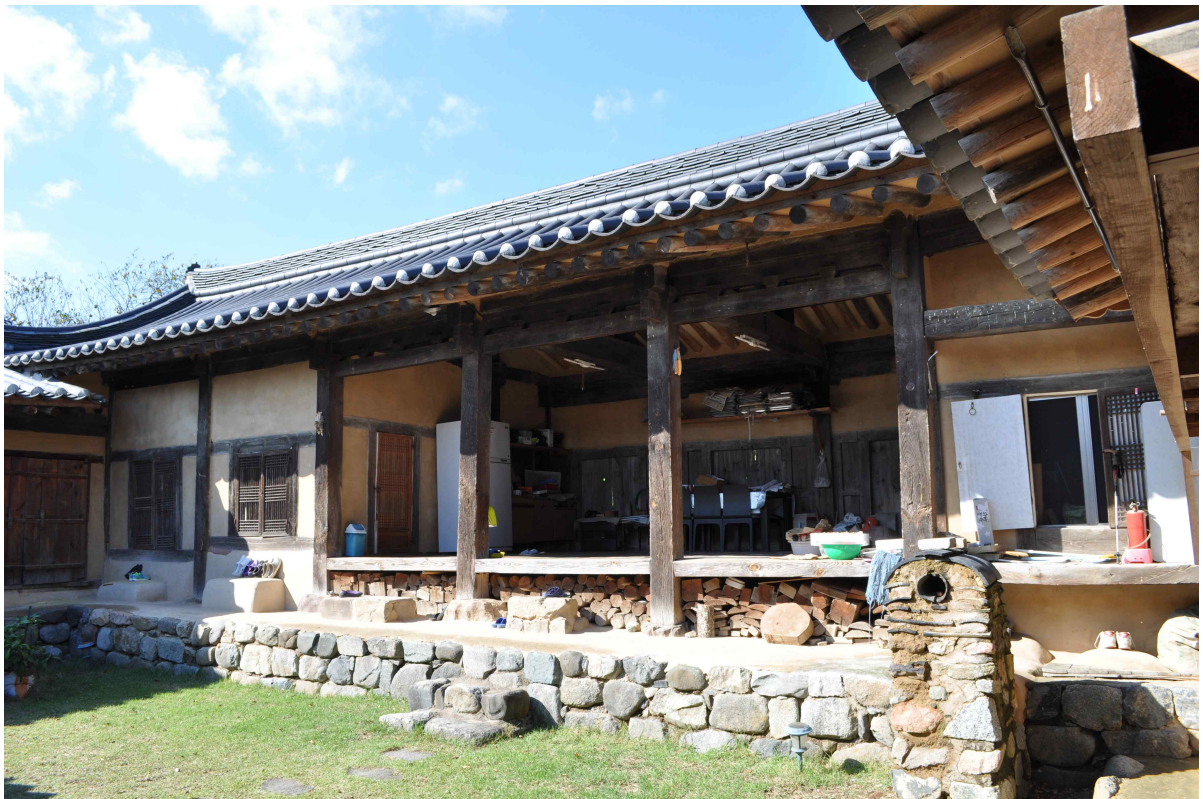
<본채 내부 전경>
