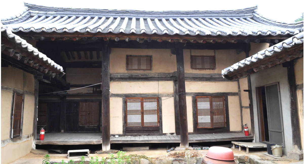
<본채 내부 전경>
