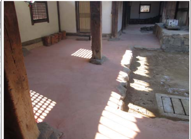
내부 기단 바닥(보수 후)
