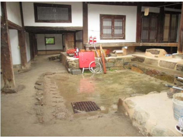
안채 마당(보수 전)
