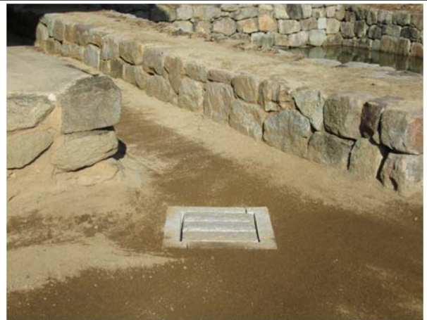
맨홀 설치(보수 후)
