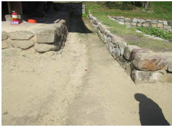
맨홀 설치(보수 전)
