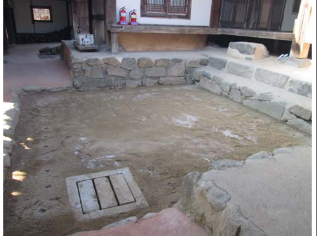
안채 마당(보수 후)
