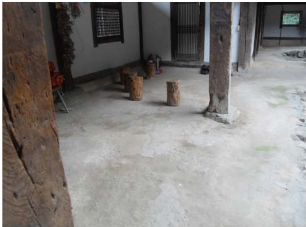
내부 기단 바닥(보수 전)
