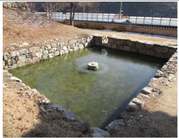
연지 준설(보수 후)
