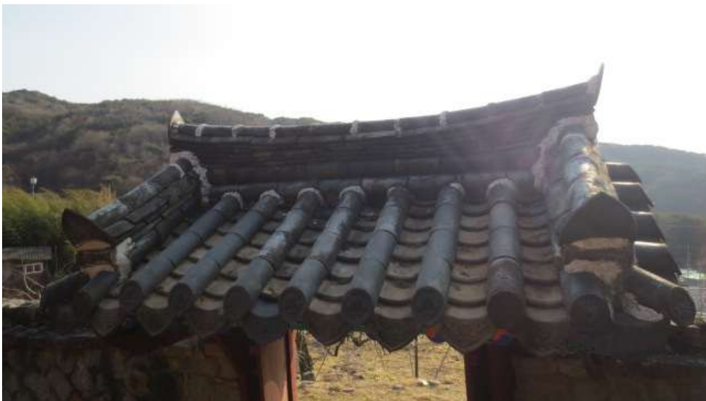
<기와 교체 작업 후(문화재자료 제46호 신송곶장군유허비)>
