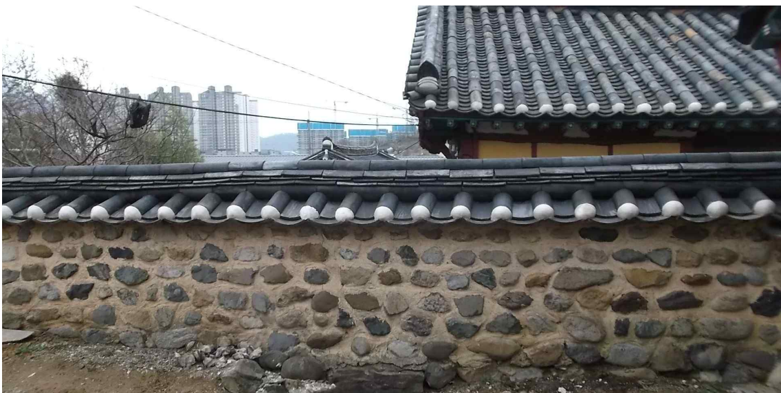
<담장과구토 보수 후(문화재자료 제27호 현풍향교대성전)>
