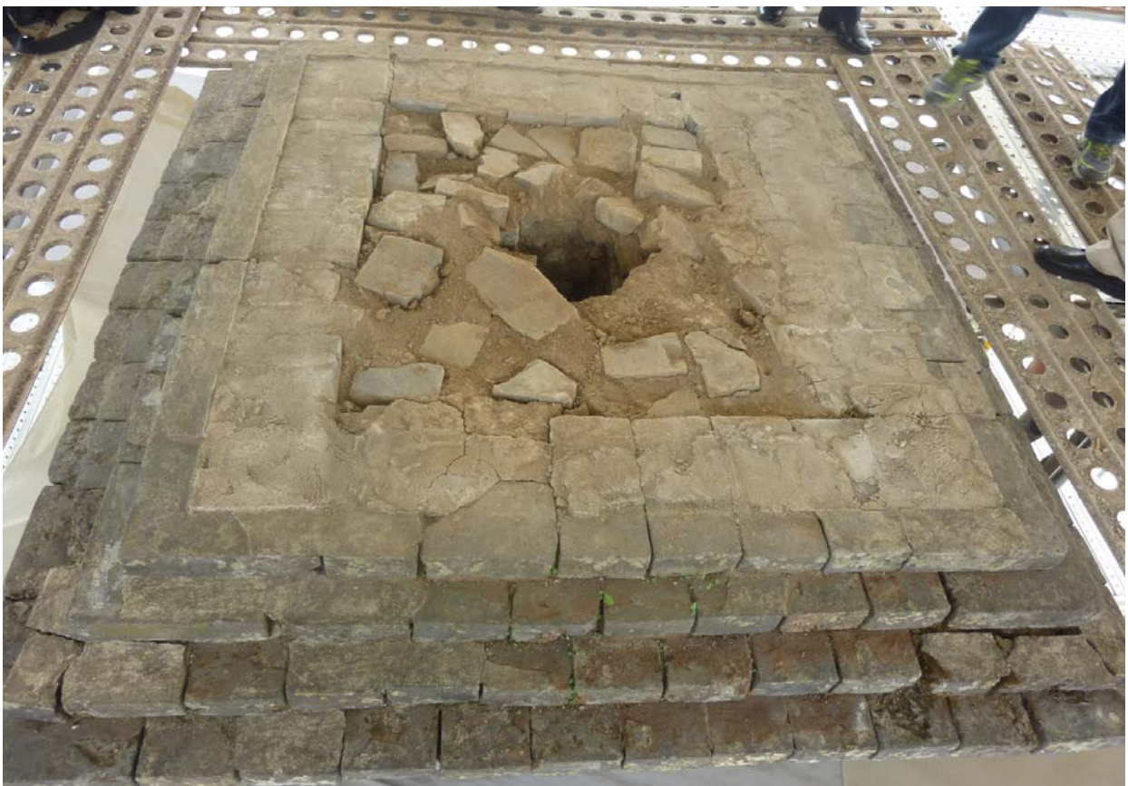
4층 옥개부 상단면 찰주공 및 적심석 현황
