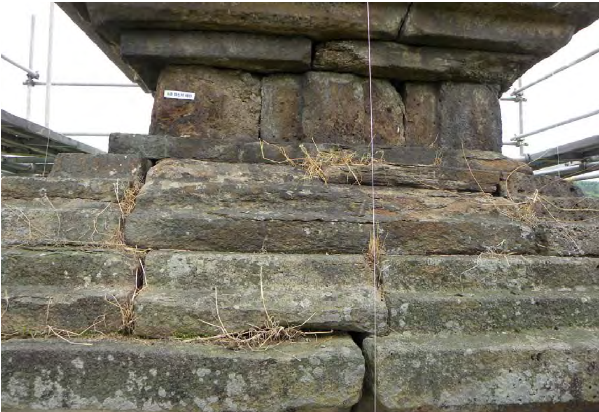
4층 옥개석 및 5층 탑신석 현황(배면)
