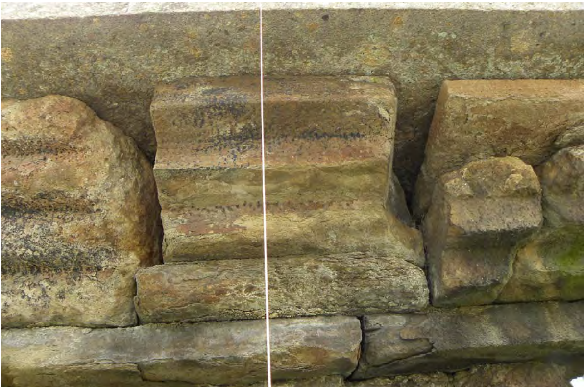
5층 옥개석 하부현황(우측)
