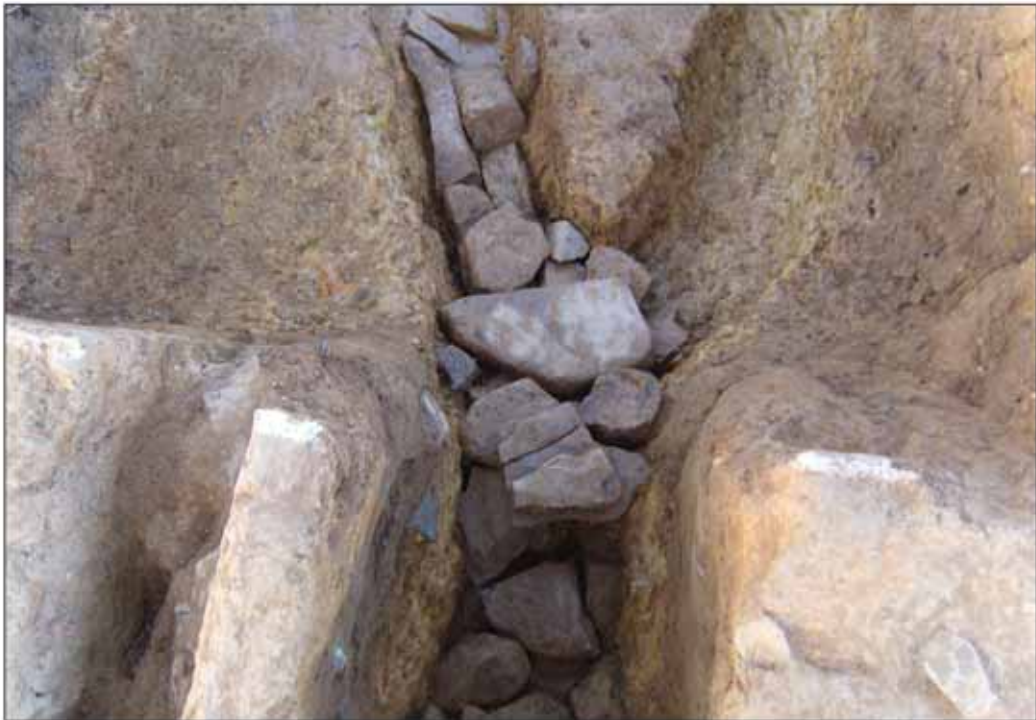
사진 17. 67호 조선시대 목관묘 배수시설 세부
