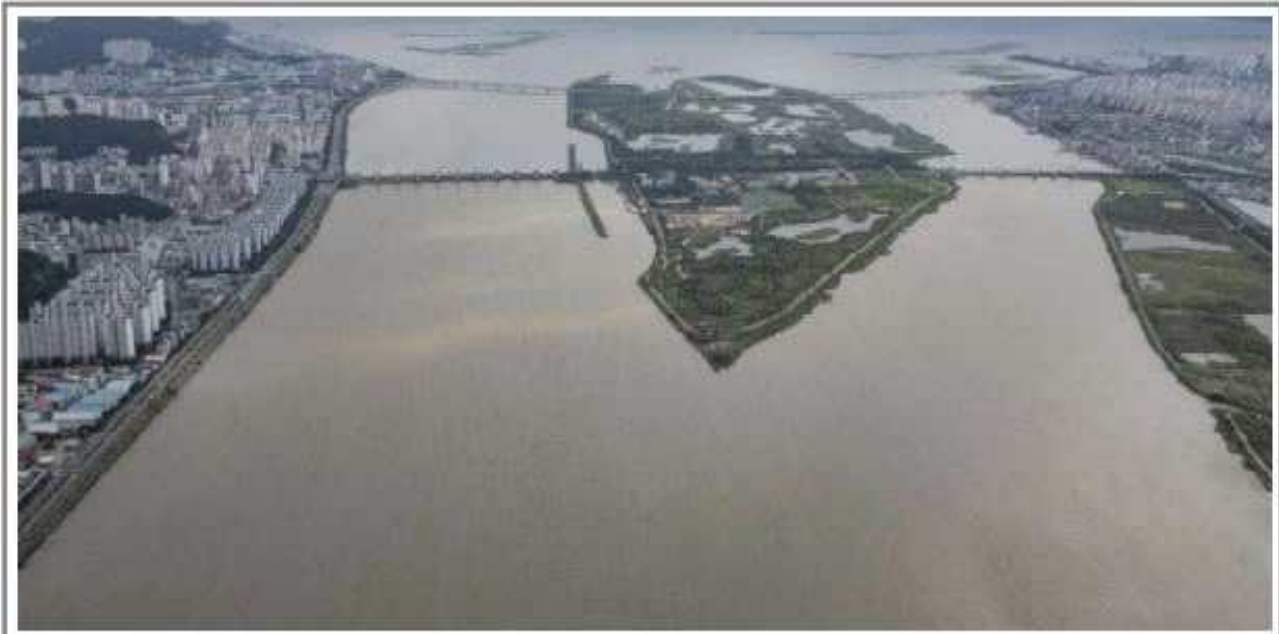
⑦ 교량 전경(북측→남측 조망)
