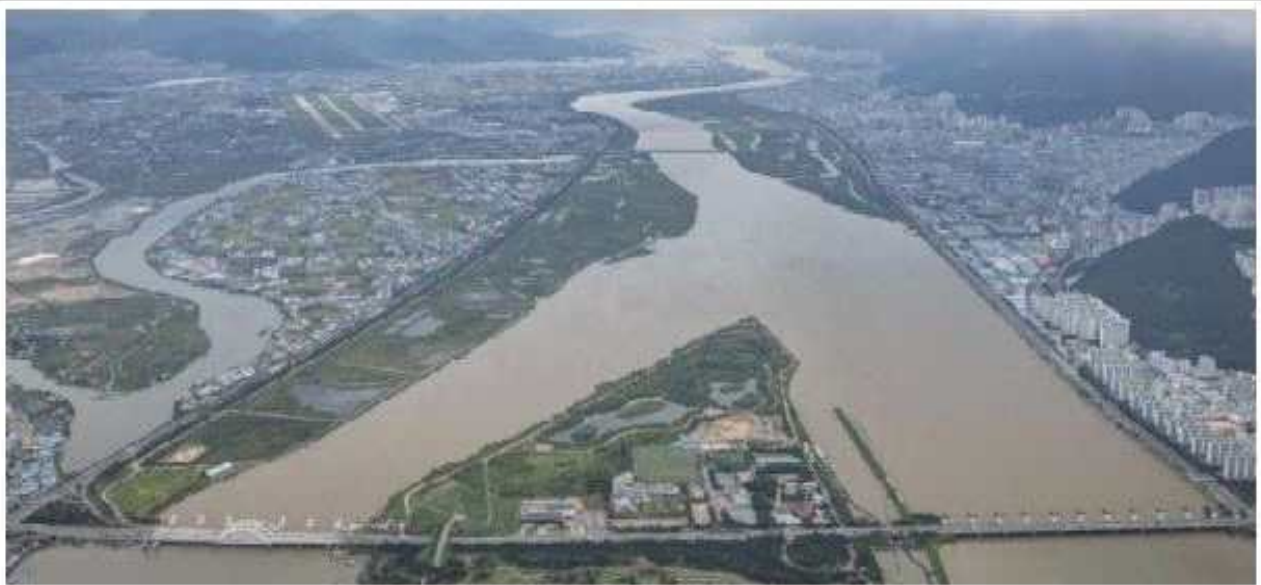
⑧ 교량 전경(남측→북측조망)
