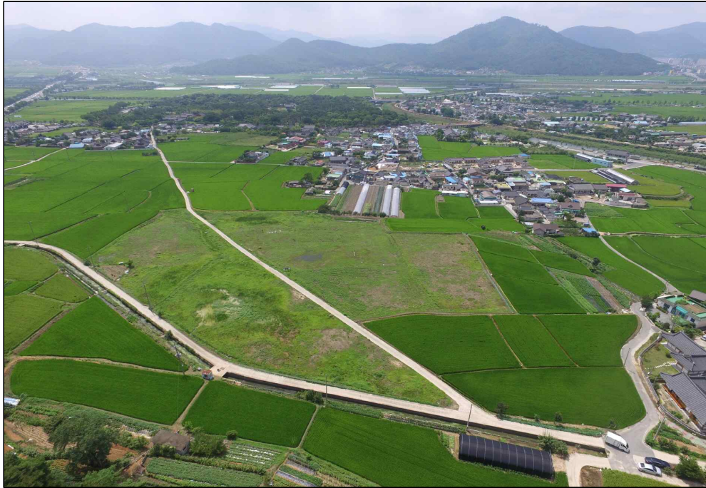
사진 12. 경주 천관사지 전경
