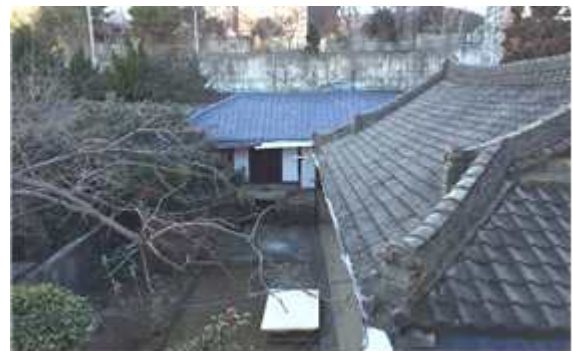
19구간 남쪽 단부 성내 인접 필지
