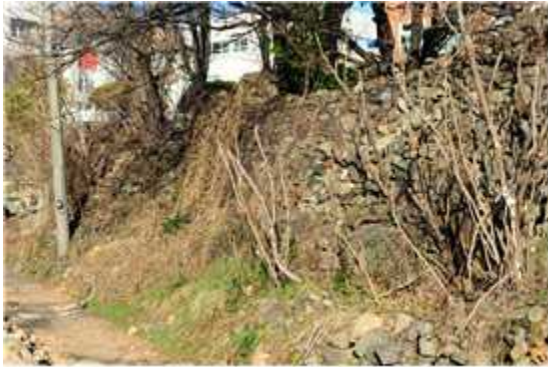
13구간 외벽 전경(2)
