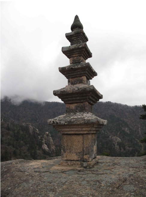
사진 1. 봉정암 오층석탑, 고려후기, 강원도 인제
