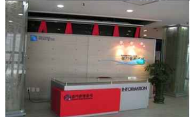
안내 데스크 설치
