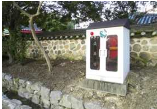
외부 소화전 설치
