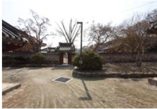
CCTV 및 전원 차단시설
