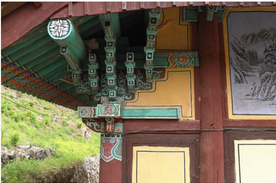
그림13.보광사 극락전 : 측면의 창방과 뒷보가 고주에 원형산지에 의해 고정되어 건조 수축에 의한 유격을 완충할 수 있도록 하였다.
