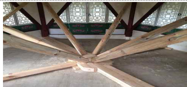
(목부재 이완 - 가새틀 설치)
