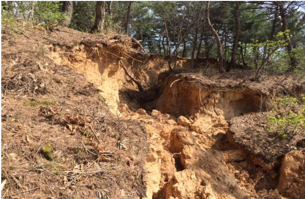
00군 00면 2.0ha 땅밀림 발생 산지 상부의 인장균열
