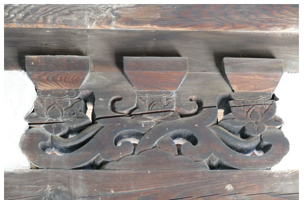
그림8. 화반 : 연화형 화반으로 투각한 조각기법 등이 고식이며 아름답음
