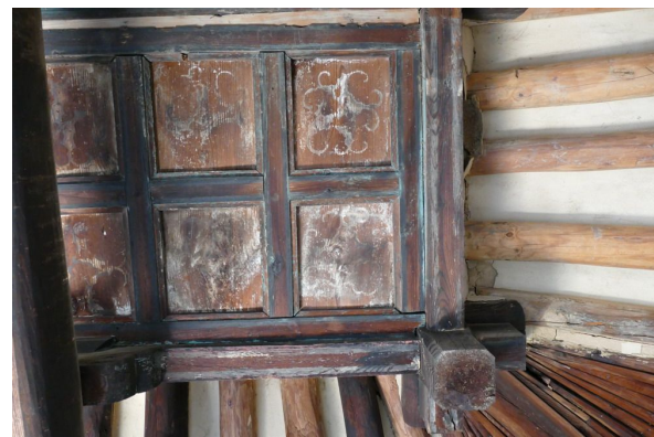
그림7. 눈썹천장 : 천장 개반에는 연화 단청이 고스란히 남아 있음
