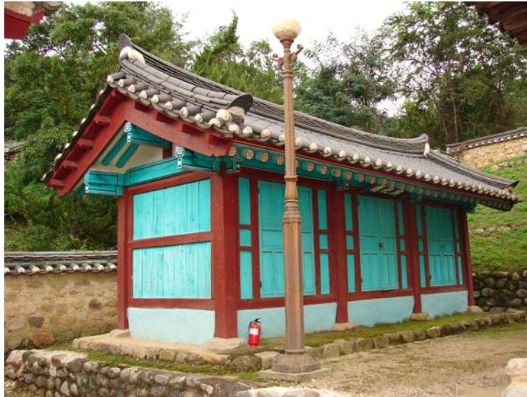
건물과 바로 인접하여 가로등 설치
