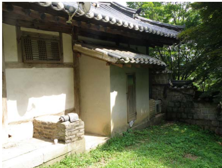
건물 외벽에 덧달아낸 보일러실
