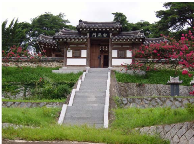
견치석 석축쌓기와 계단설치 재료 및 형태의 부조화
