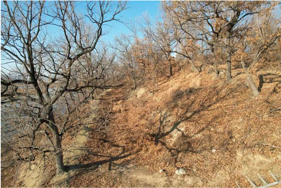
개운포 좌수영성 서쪽 구간 마른 해자(隍)
