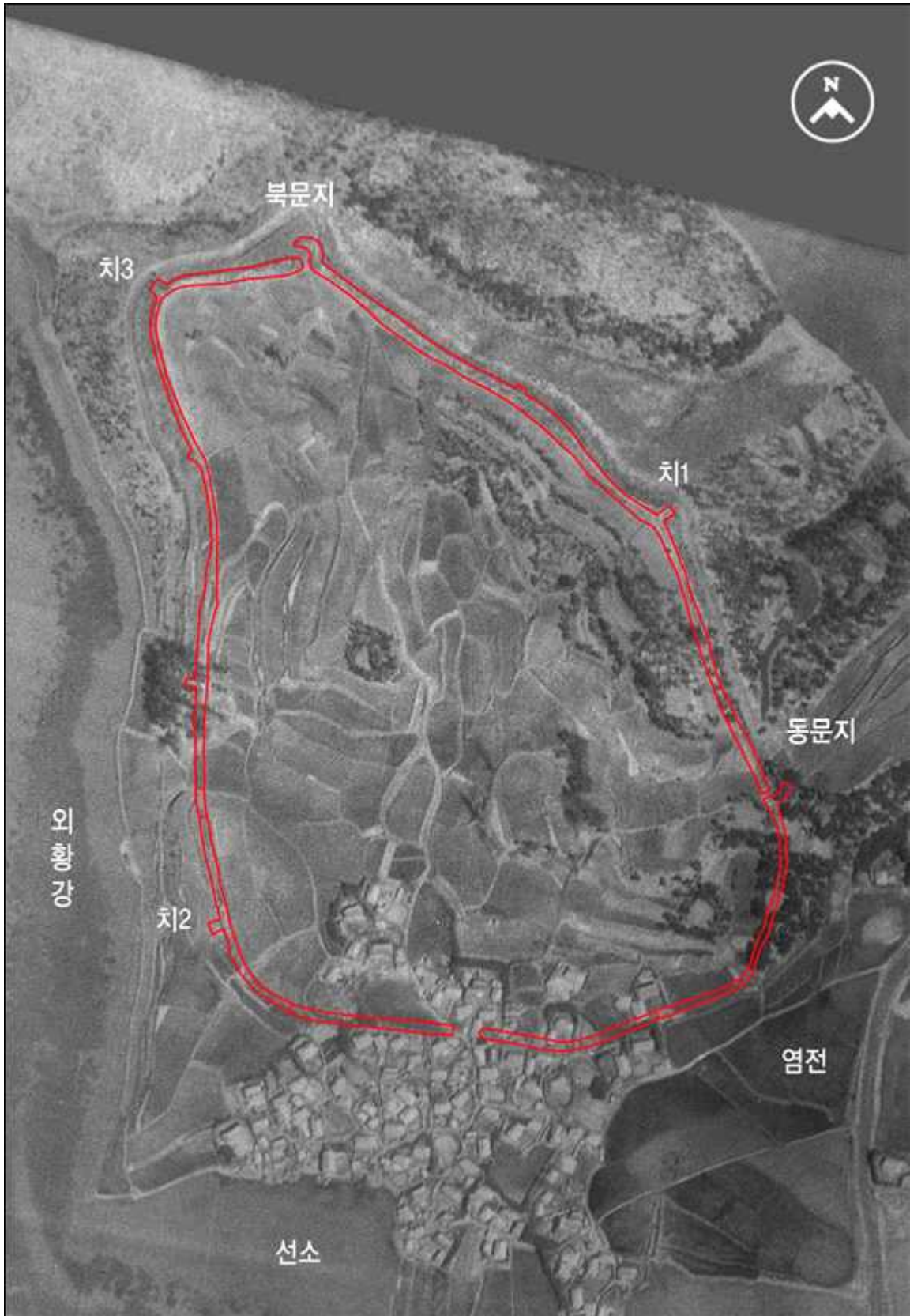
개운포 좌수영성의 성벽 위곽도, 1954년 항공사진, 국토지리정보원
