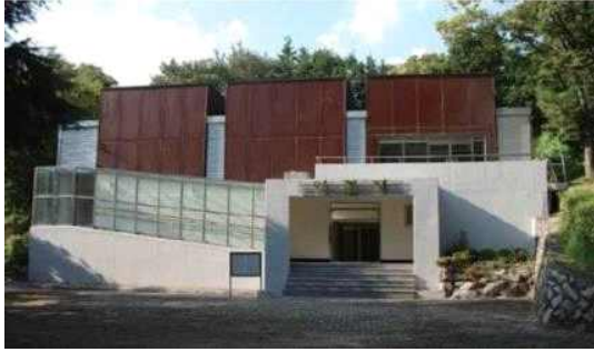
야철지 보호시설 전경
