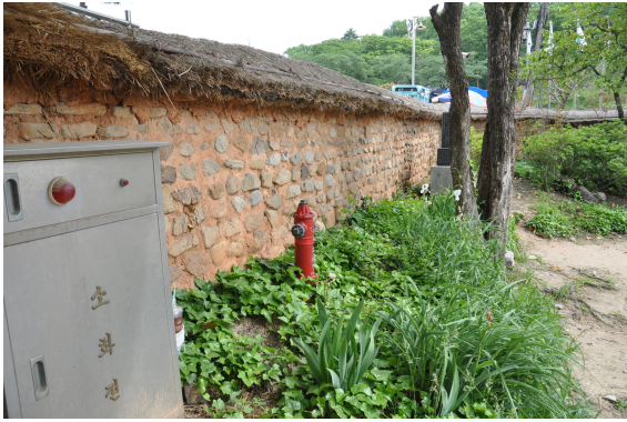
그림 4. 호스릴 설치 전 (기존의 옥외소화전)
