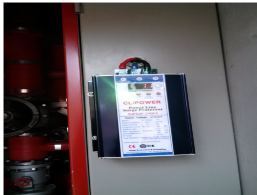
그림 12. 문수사 낙뢰보호기 설치
