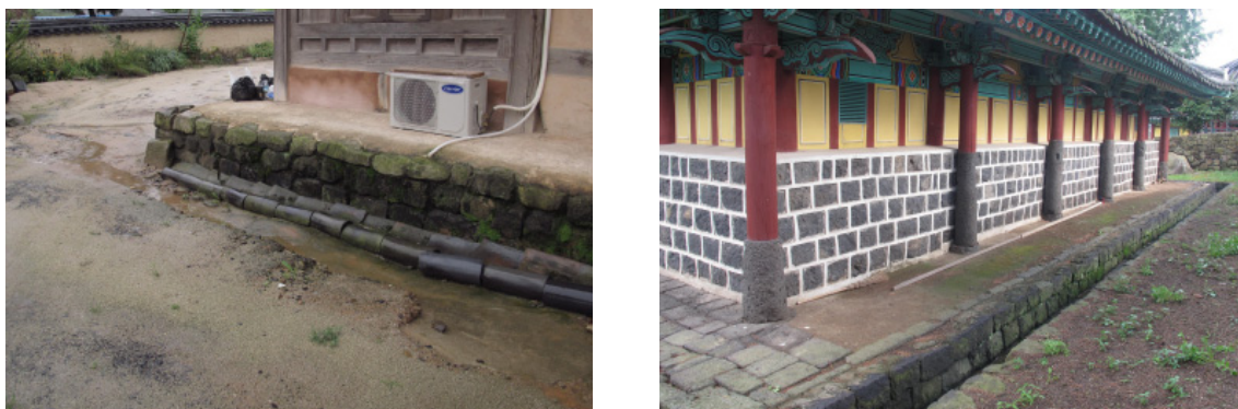
그림 13. 배수로 없이 물길을 내준 모습(좌)과 정비된 배수로(우)
