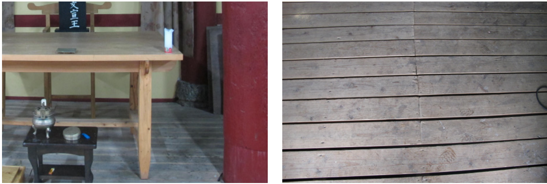
그림 19. 목조건축물 내부의 관리 우수사례(목재 파라트 설치)
