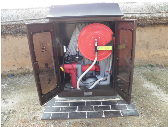
그림 13. 호스릴 설치 양호 사례
