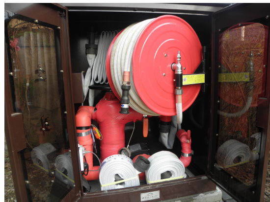
그림 14. 호스릴 설치 미흡 사례
