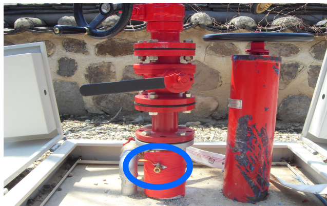
그림 3. 방수총 하단에 설치된 퇴수밸브
