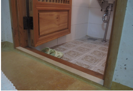
화장실 습기제거 및 개방
