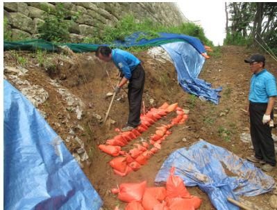
여장 줄는 보수 및 폭우에 침식된 곳 응급복구
