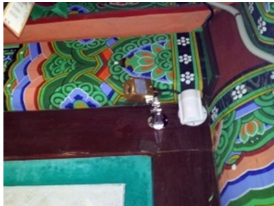
실내 화재감지설비 설치 (당진 영탑사)
