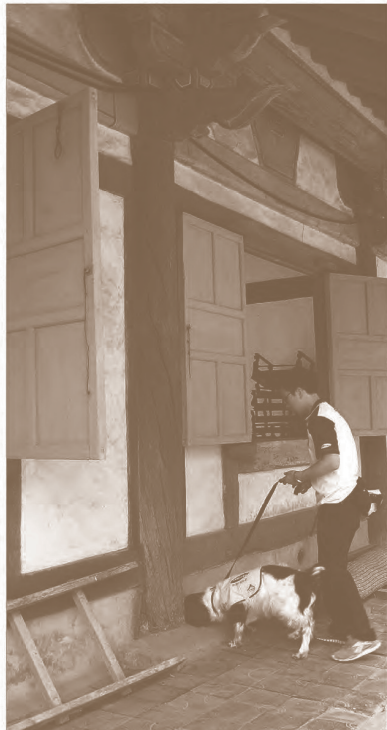
흰개미 탐지견 보양이 훈련서 이원희씨의 안내를 따라 경주향교 목조 기둥의 냄새를 맡고 있다. 흰개미 탐지견의 서식 흔적 탐방 보양이는 원래 폭발물 탐지에서 흰개미 탐지로 '전공'을 옮겼다.
