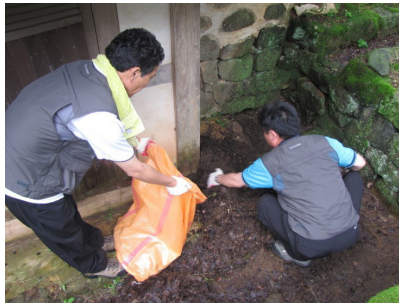
배수로 점검 및 청소
