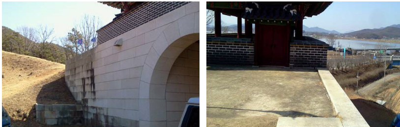
암석의 오염 상태 및 성문 진입부 바닥 이격 상태 확인
