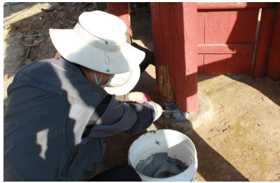
방충제 도포 및 부후된 기둥하부 보강작업
