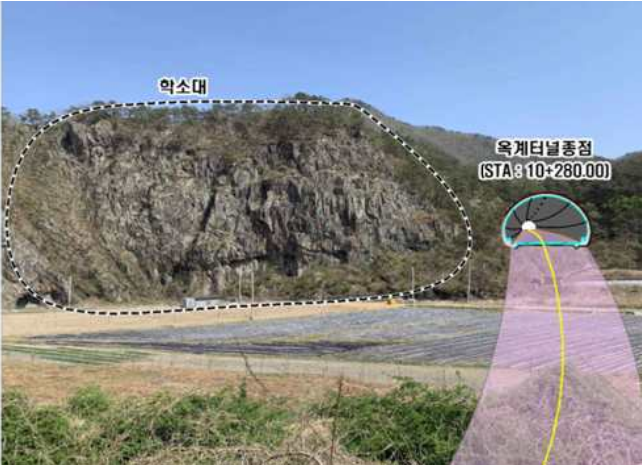
<교량 설치 구간 현황>
