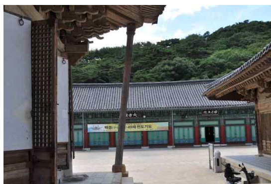
그림 3.32 양산 통도사 대웅전 및 금강계단 (활주)
