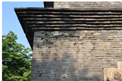
그림 3.21 경주 분황사 모전석탑 (전돌 균열 및 이격)
