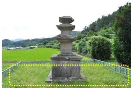
그림 3.9 밀양 송진리 삼층석탑 (잔디 식재로 인한 배수 저감)
