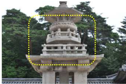
그림 3.15 경주 불국사 다보탑 (부재 형태-가구식 복합부재)
