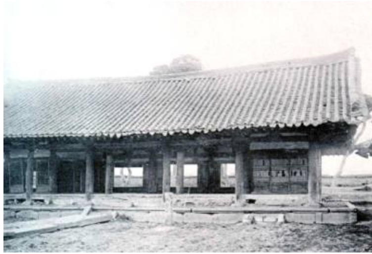
그림 53 『조선고적도보』의 명륜당 사진 - 기단이 지금보다 높아서 하단이 면석처럼 보이고, 처마끝의 활주가 없다. 또 온돌방 앞의 창호도 현황과 다르다. (『보고서』에서 전제)
