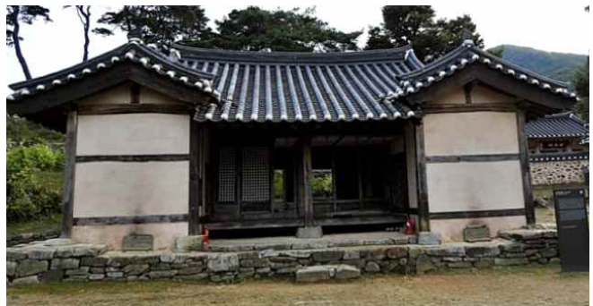
그림 41 아산 맹씨행단 정면(工자형 지붕)
