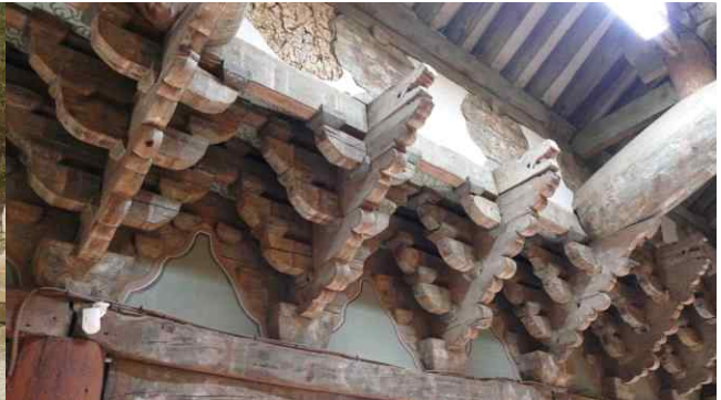
그림21.침차 모양이 측면을 사절한 고식이며 내외출목이 같아 도리하부 화반장식이 특징적
