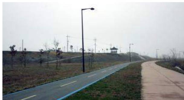
군수제 전경(제방 하부)
