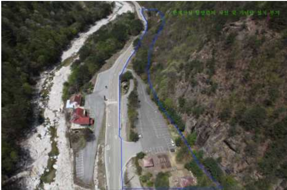
인제 한계산성 탐방편의시설 및 기념탑 설치 부지
