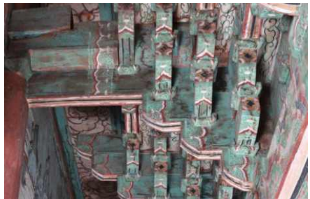
후면 내부공포 사제공과 내부고주의 결구
