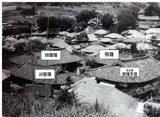
통영 하동집 철거전 전경
