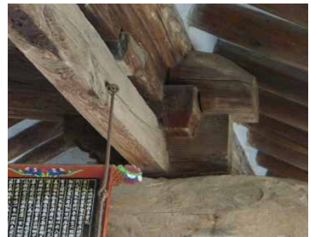
그림 30 대청 상부에 꾸민 간략한 포대공 형식의 종보 받침
