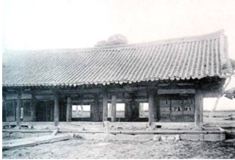
그림 53 『조선고적도보』의 명륜당 사진 - 기단이 지금보다 높아서 하단이 면석처럼 보이고, 처마끝의 활주가 없다. 또 온돌방 앞의 창호도 현황과 다르다. (『보고서』에서 전재)
