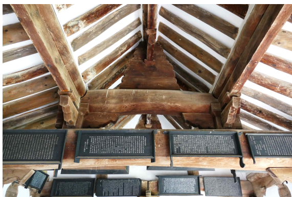
명륜당 대청 상부 지붕 가구
