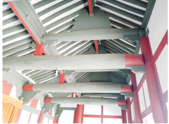
그림 127 대성전 상부가구 및 내부 단청
