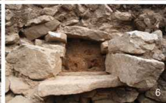
서쪽계곡부 체성(1: 내벽 전경, 2: 외벽 전경, 3 · 4: 전체 전경, 5: 입수구 전경, 6: 퇴수구 전경)
