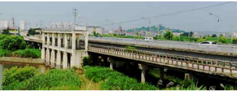
그림 3 교량 및 방조수문 전경(시점부▶중점부)
