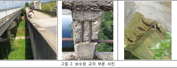
그림 2. 보수된 교각 부분 사진
